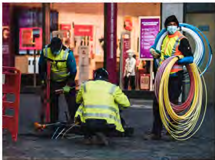
Detenuti impegnati nella posa della fibra ottica
