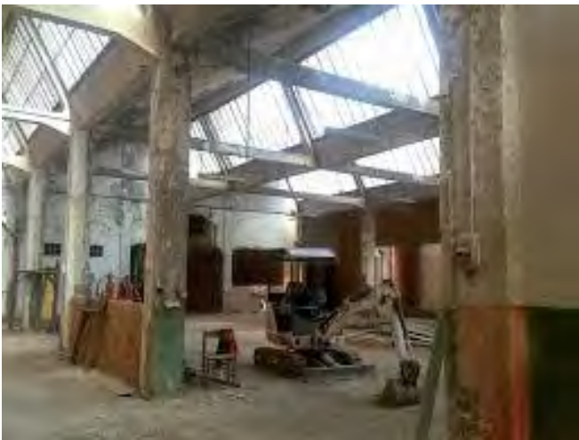
(17.1) IPM Ferrante Aporti Torino – Lavori di ristrutturazione area detentiva – anni 2000
