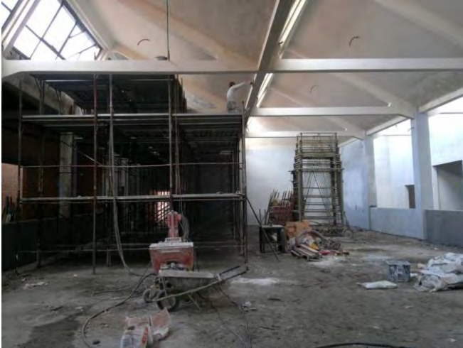
(16) IPM Ferrante Aporti Torino – Lavori di ristrutturazione area detentiva – anni 2000
