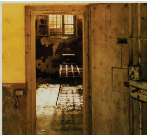
Abbiategrosso via Carabelli - palazzo de "Il camerotto" cella del carcere
