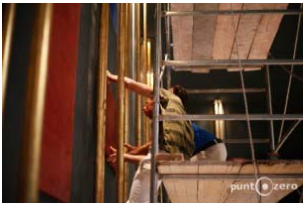
Ristrutturazione del teatro (ph. Puntozero)
