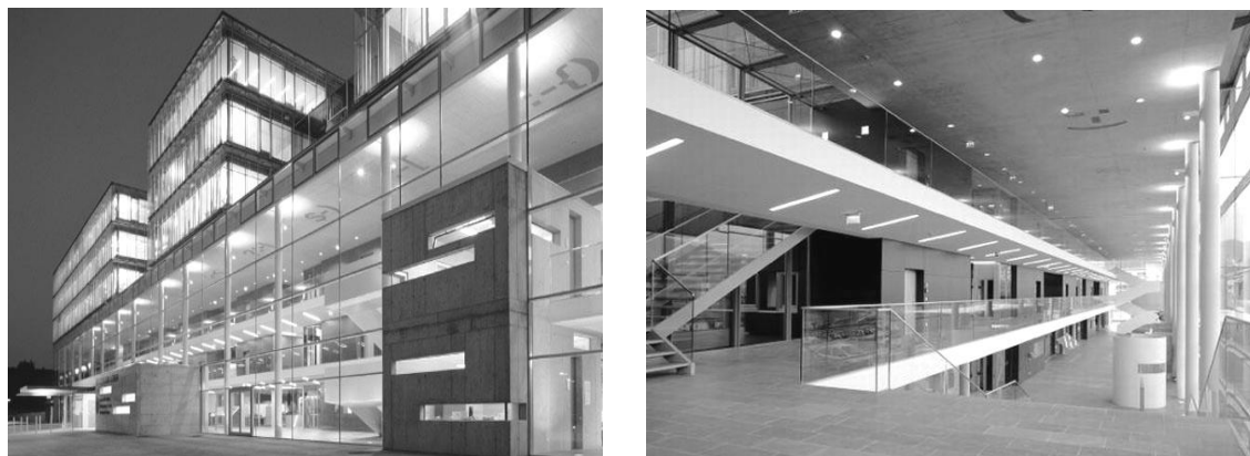
Fig.8 - Leoben Justice Centre nella Stiria in Austria. La facciata esterna del carcere e un corridoio di servizio. Ciò che rende particolarmente interessante ed unico nel suo genere questo complesso penitenziario è lo spazio e la “trasparenza” ambientale. La quasi totale rinuncia a componenti percettivamente “dure”, quali sono i cancelli, le inferriate e gli sbarramenti (elementi caratteristici del carcere classico) connota, attraverso il nuovo significato spaziale e materico, un esplicito valore di fiducia e dichiara una civile considerazione nei confronti del particolare tipo di “ospite”. La dignità dello spazio e dell’ambiente è strettamente legata al valore umano del detenuto e dei suoi diritti 643 .
