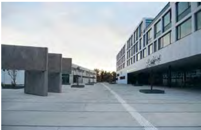
Justizzentrum Korneuburg, Austria
