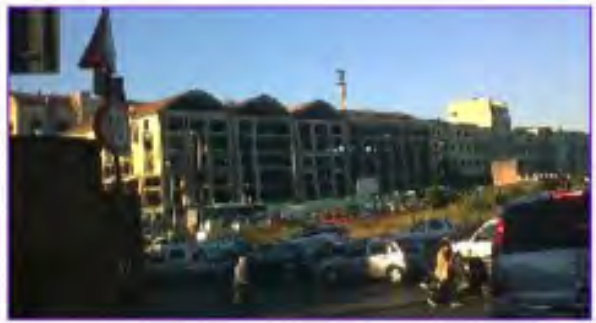
EDIFICIO DISMESSO Via Tiburtina
