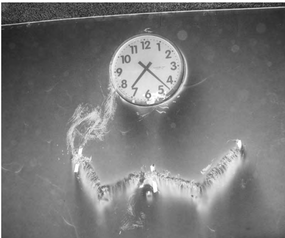
Nella pagina accanto e qui sopra i danni causati dall'incendio
